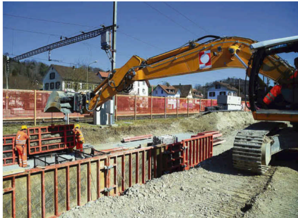
Start eines längeren Bauprojekts: In Rikon wird derzeit für die Modernisierung der Tösstallinie gearbeitet. Bild: Marc Dahinden
